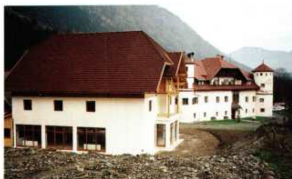
Nouvelle salle à manger du Centre de Conférence de Neustein en Autriche
