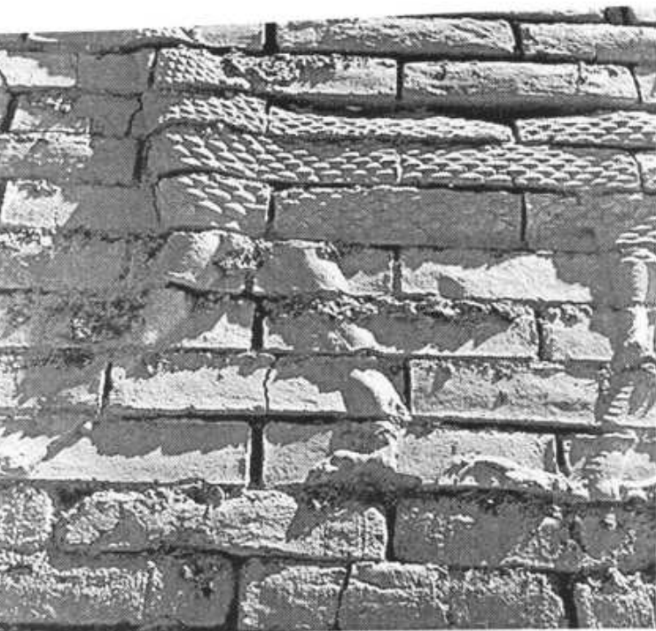
Mur de la ville de Babylone avant sa restauration.
