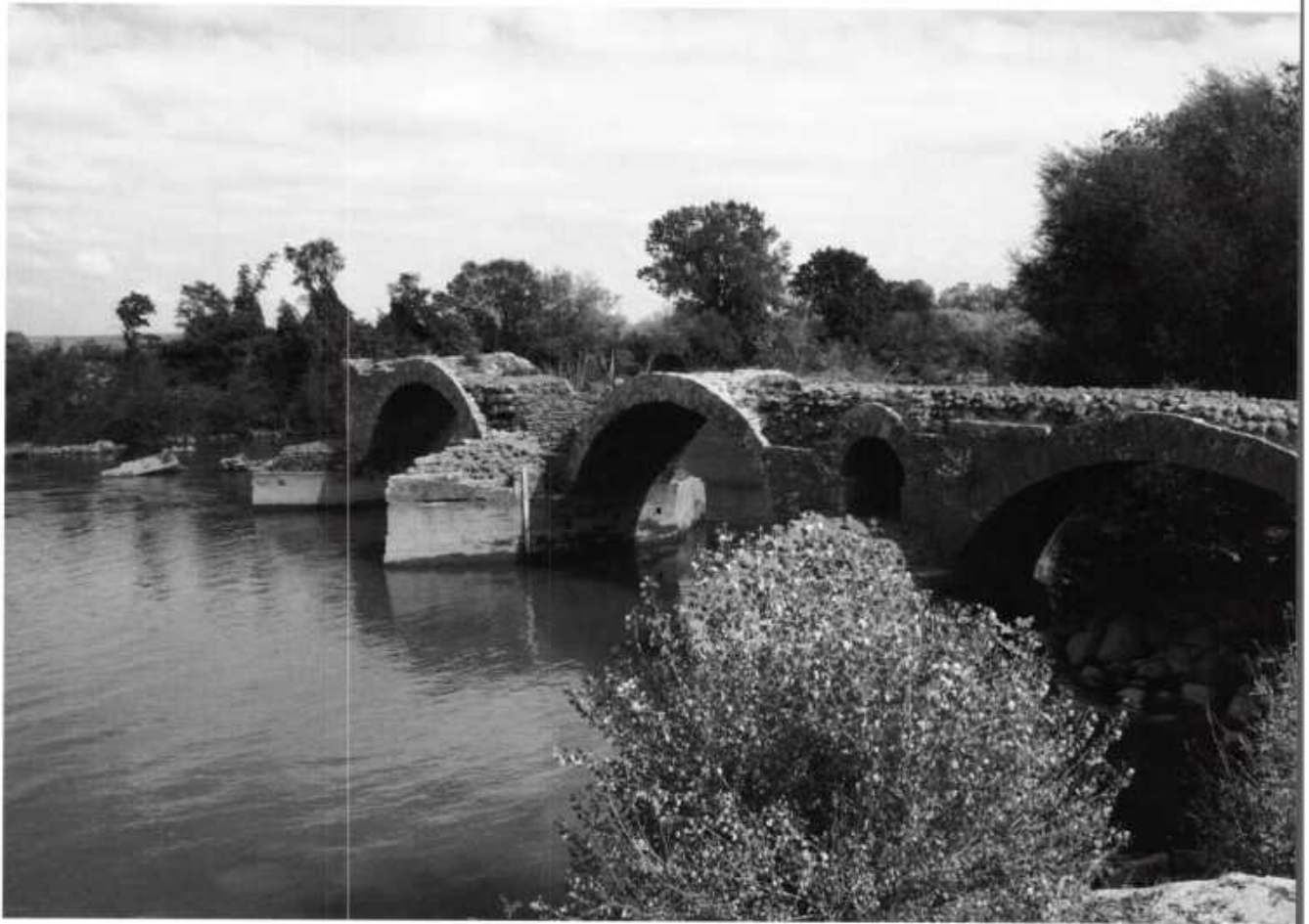
Vestiges du pont romain de Saint Thibéry situé près de la Via Domitia. La Via Domitia reliait l'Italie à l'Espagne, à travers la Gaule Narbonnaise et la Provence actuelle (Sud de la France).
